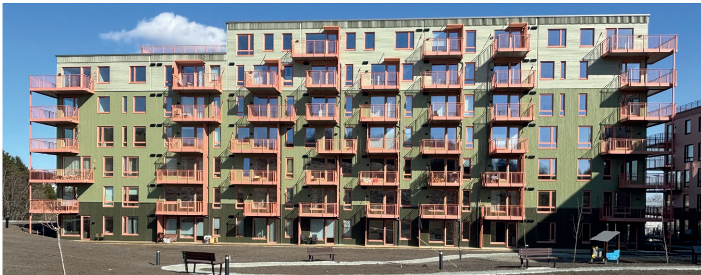
Rikelig med balkonger mot sør i blokk A.
