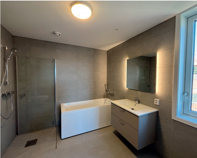
Plassbygd bad i en av de tre leilighetene som skiller seg ut med areal over 100 kvadratmeter og ekstra store takterrasser.
