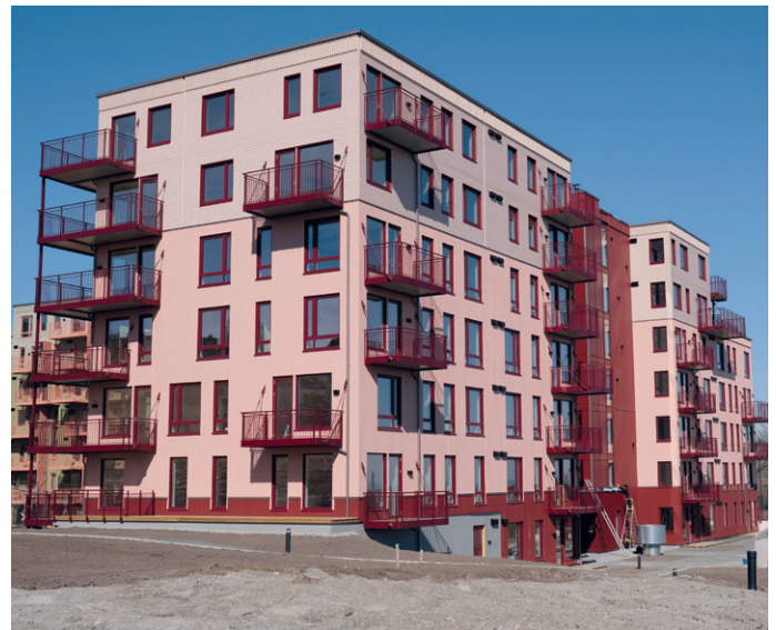
Sør- og østveggen på blokka som ble ferdigstilt til 1. mai.
